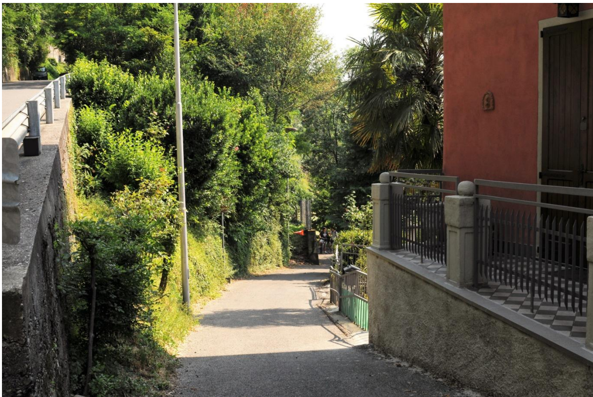
Figura 28 - Ambito 3 - Casa di cui alla Figura 9 e 12 In questo punto l'area era stata erroneamente classificata in classe 4Fa. Si evince invece la sua totale esclusione da fenomeni franosi ,sia per le condizioni morfologiche al contorno sia a seguito delle protezioni eseguite sulle due strade che la delimitano a monte.
