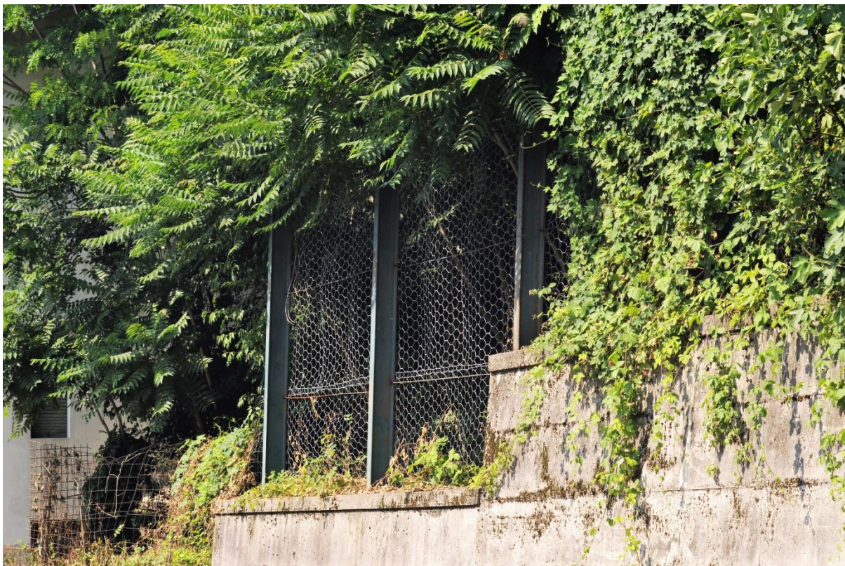
Figura 22 - Ambito 3 - Dettaglio della struttura di protezione (muro più rete paramassi). Un sopralluogo da noi eseguito sul retro della rete ha permesso di confermare la sua efficacia in termini di protezione.
