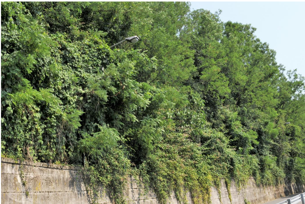
Figura 24 - Ambito 3 - Condizione delle coperture vegetale nel periodo estivo che impedisce di comprendere le condizioni morfologiche del versante e di valutare l'efficacia delle opere di difesa realizzate, portando all'errore di valutazione sullo studio del 2007
