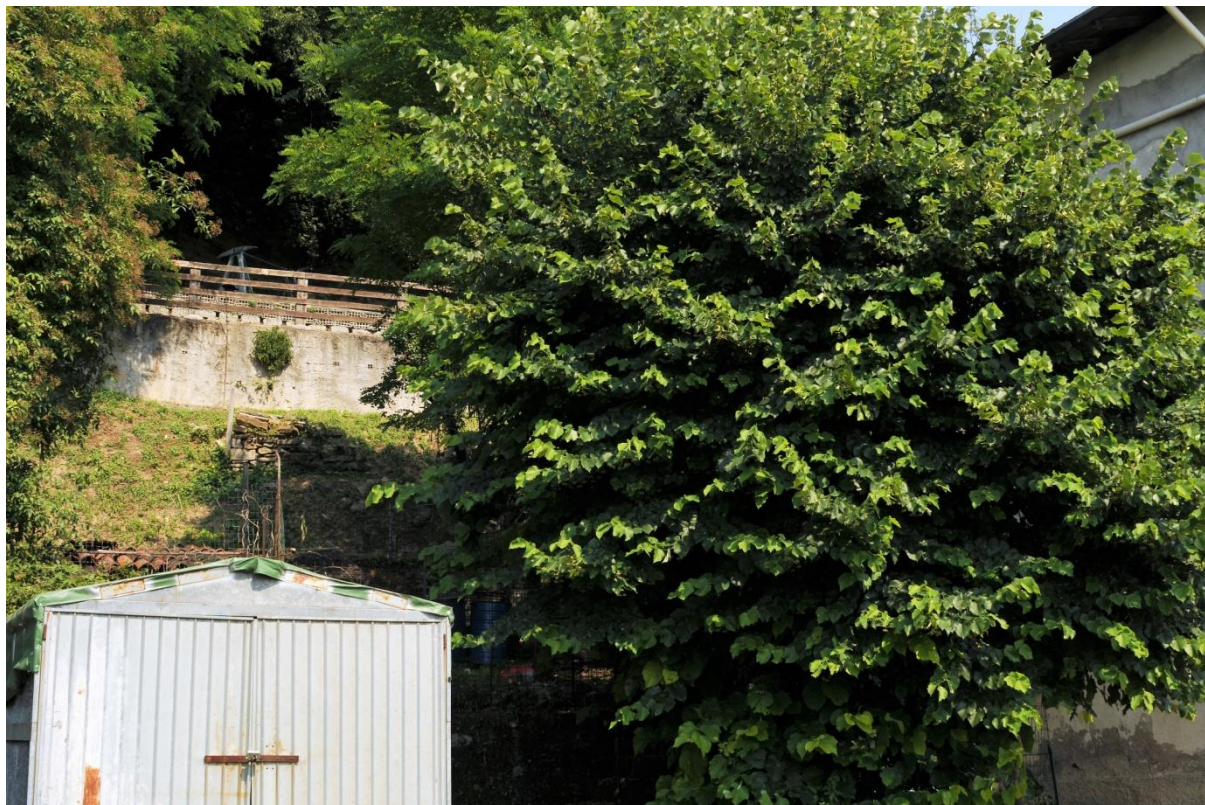
Figura 30 - Ambito 4 - Il piede del versante è caratterizzato dalla presenza di alcuni edifici e autorimesse, protetti da una serie di muri eseguiti a monte con lo scopo di ridurre i fattori di rischio.
