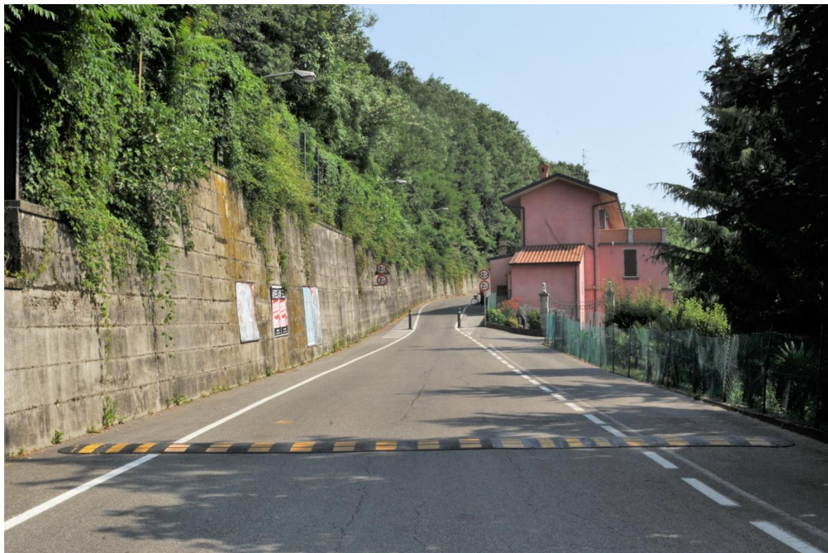
Figura 19 - Ambito 3 - Visione complessiva della strada, in cui si evidenzia sulla destra l'edificio illustrato nella Figura 9 e sulla sinistra l'imponente opera di protezione.
