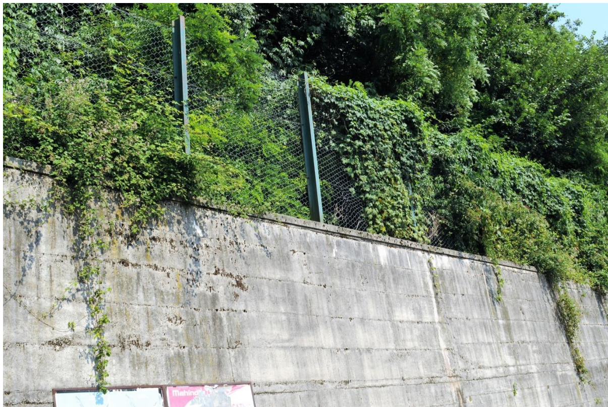
Figura 23 - Ambito 3 - Ulteriore dettaglio dell'opera di protezione posta più a monte sempre lungo la strada per il centro di Paladina
