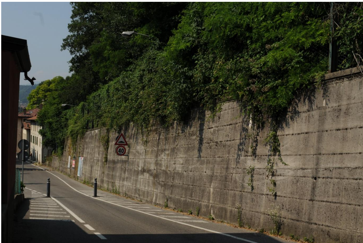
Figura 27 - Ambito 3 - Visione dall'alto verso il basso dell'imponente muro di contenimento
