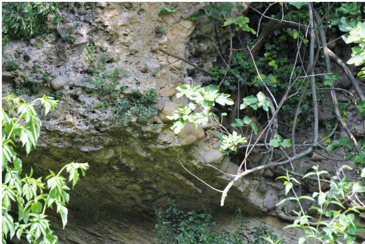
Figura 32 - Ambito 4 - Dettaglio dell'elevato grado di cementazione del conglomerato fluviale
