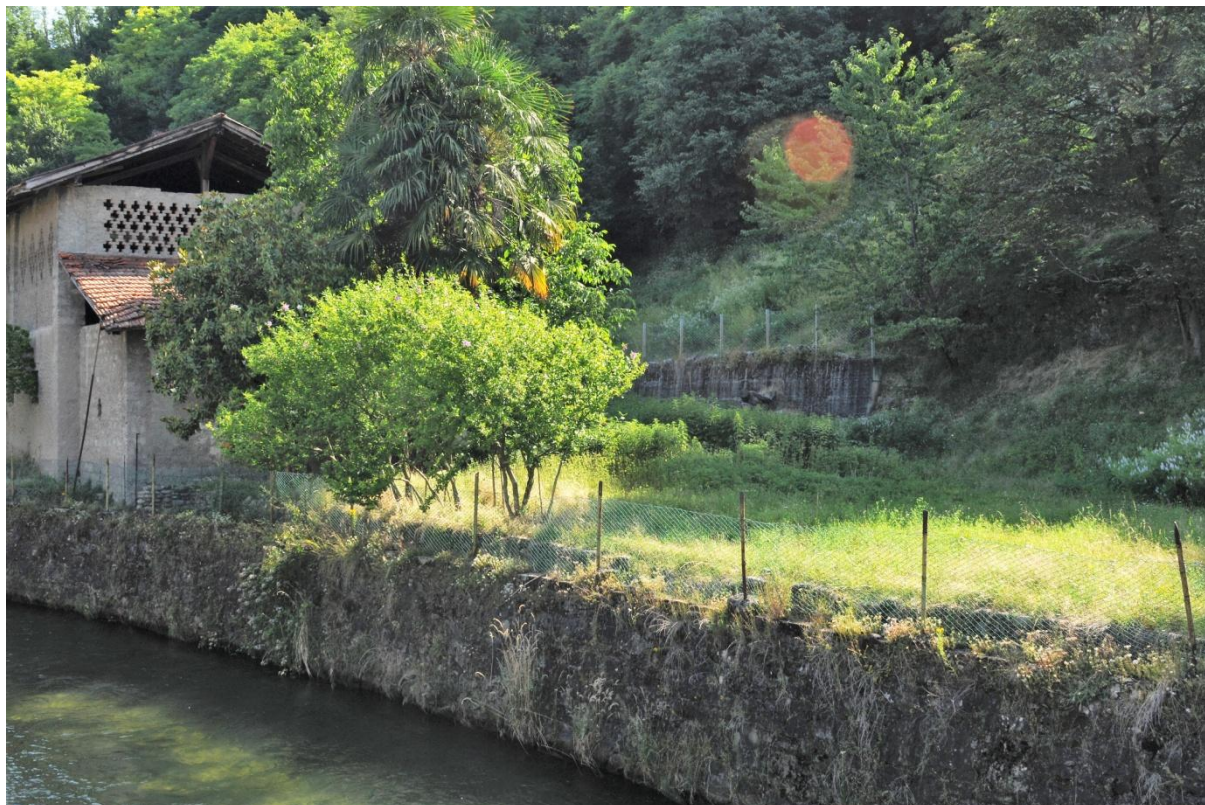
Figura 5 – Ambito 1 - Area in continuità con quella precedente, ma oggetto di modifica da "Fa" ad "3 idrg". Si noti la presenza di muri di contenimento sulle scarpate
