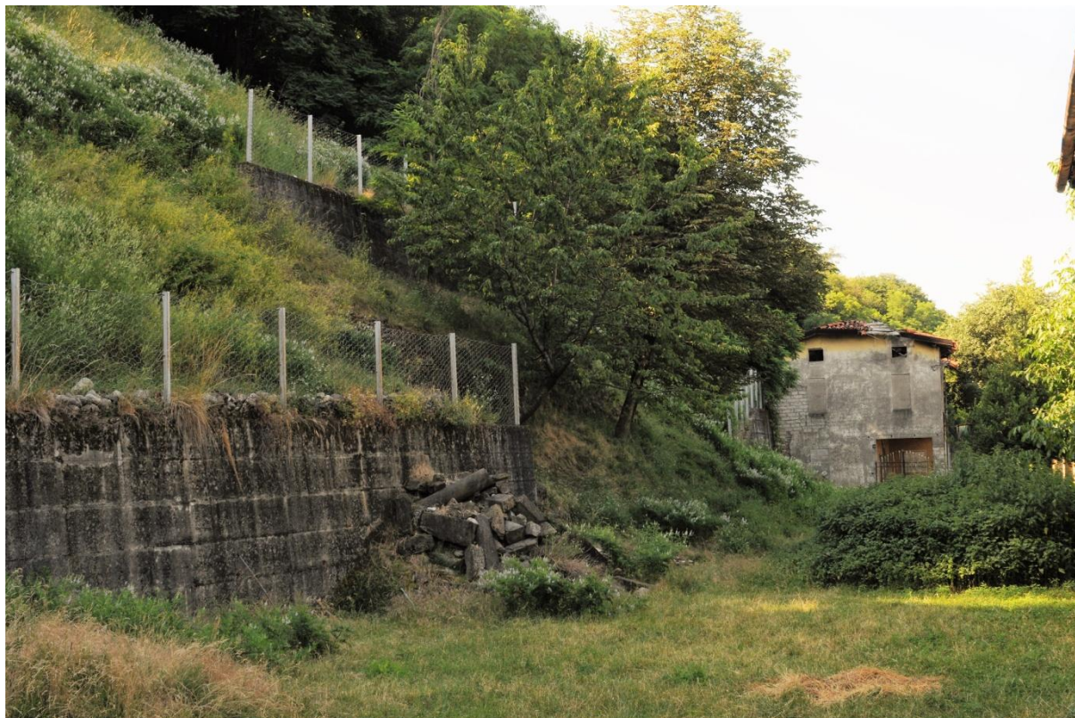
Figura 10 – Ambito 1 - Altri muri di contenimento della scarpata in ceppo, con sovrapposte rete di protezione in cui si vede chiaramente la funzione svolta di contenimento di piccoli sassi
