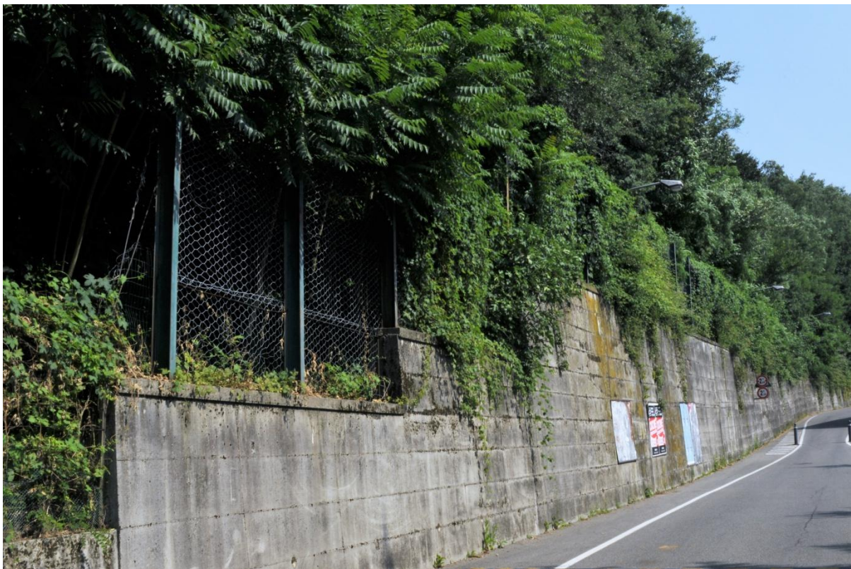
Figura 18 - Ambito 3 - Strada che porta all'abitato di Paladina, si noti che nel. lato di monte è stato necessario realizzare un imponente muro di contenimento con sovrapposta una rete paramassi.
