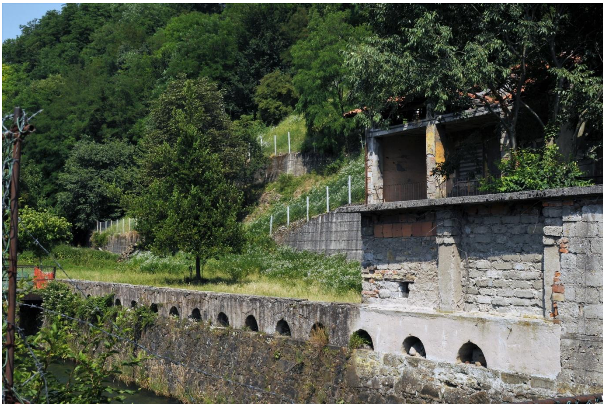
Figura 6 – Ambito 1 - Dettaglio dei muri di protezione
