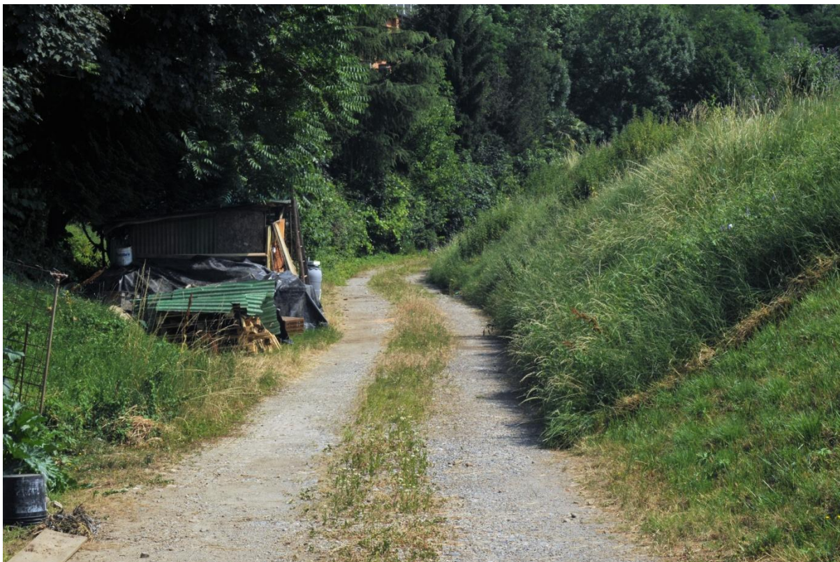
Figura 17 - Ambito 3 - Dettaglio del vallo tra il canale Legler e a sinistra il piccolo versante che stacca dalla strada per il centro di Paladina.
