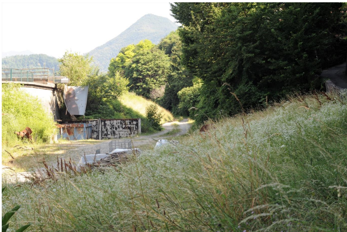
Figura 13 - Ambito 2 - Dettaglio del canale sopraelevato che genera un vallo naturale, tra la scarpata e il versante.
