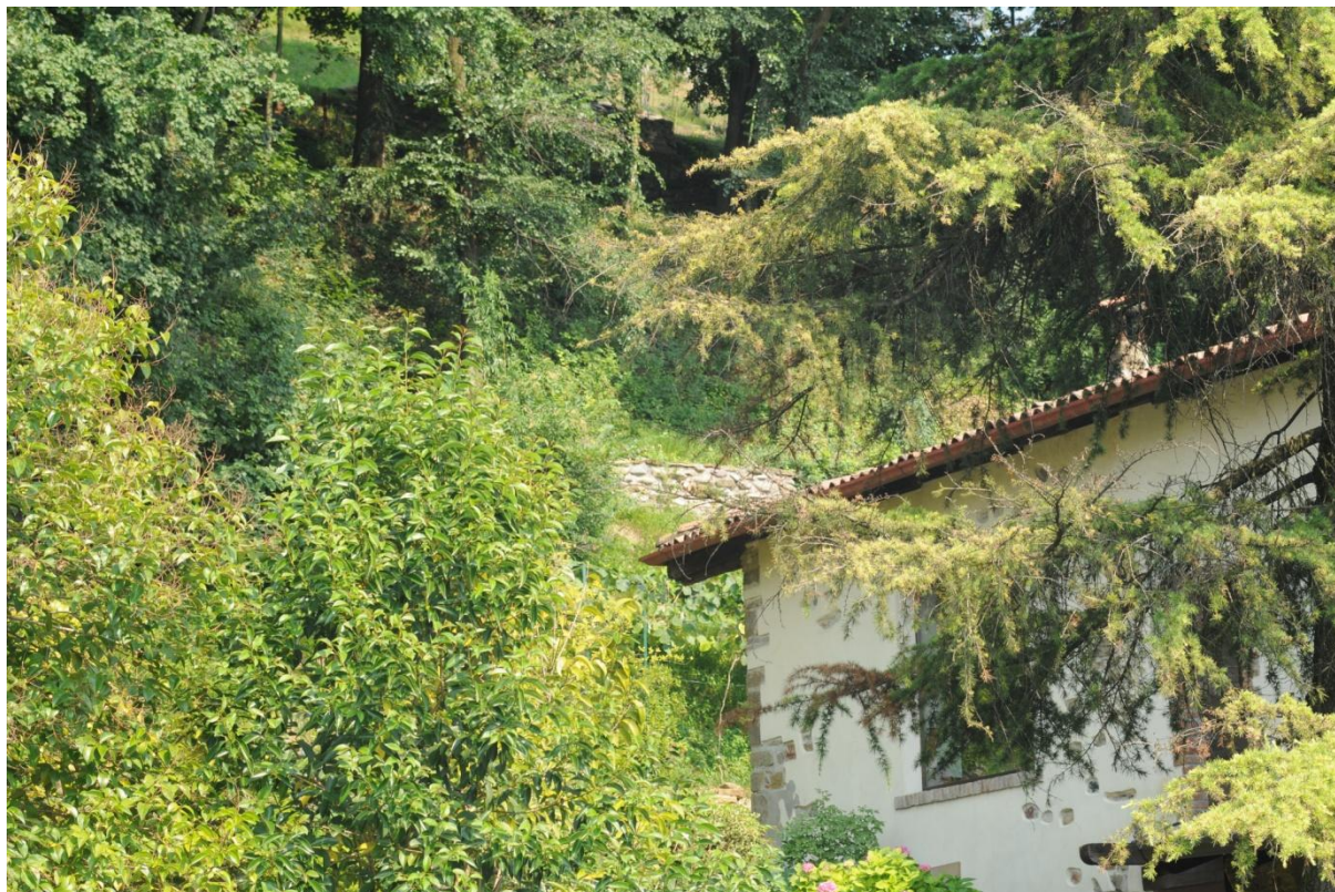
Figura 35 - Ambito 5 - Muri di contenimento eseguiti sul versante
