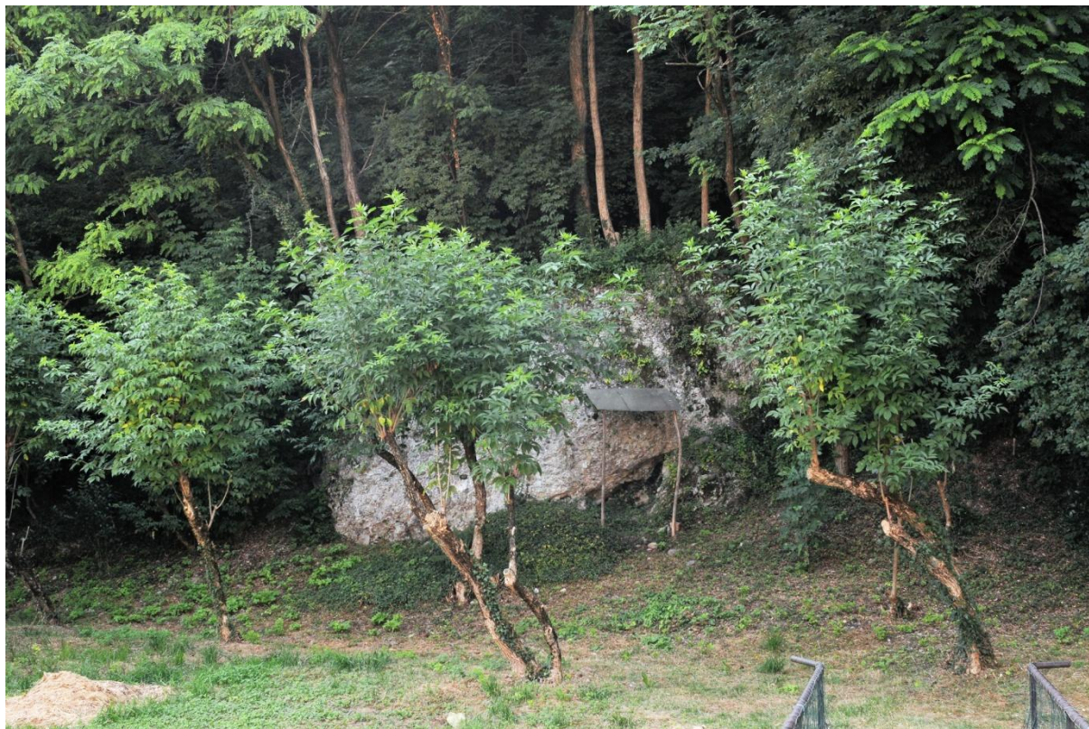
Figura 2 - Ambito 1 - Vecchi blocchi di materiale di notevole dimensione già caduti dal versante, area confermata in "Fa"
