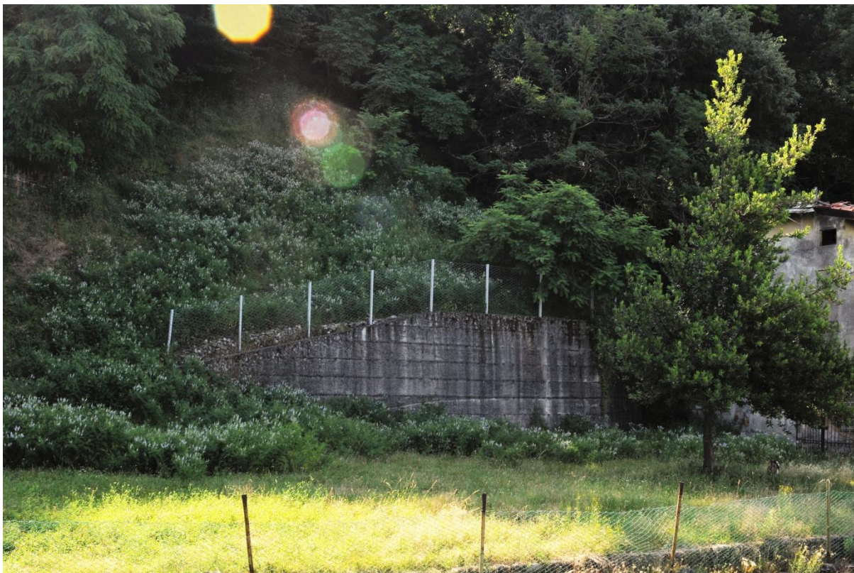
Figura 7 – Ambito 1 - Dettaglio dei muri di contenimento sul retro dell'area proposta per la modifica
